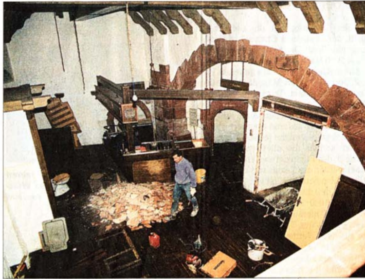
Die Bauarbeiter haben begonnen die letzten Reste der alten Inneneinrichtung der Gaststätte im »Riesen« zu entfernen. Im Frühjahr will der neue Pächter, die Brauerei Faust, wieder eröffnen.
